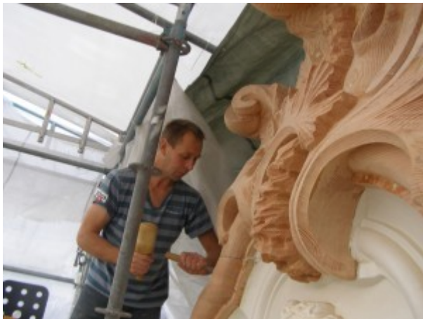
De kuif wordt geplaatst op het gerestaureerde gevel ornament aan de Prinsengracht 126.
